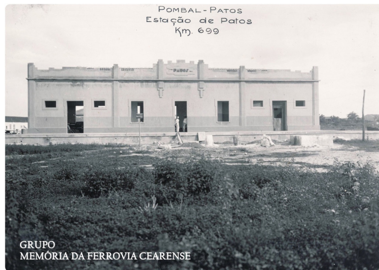
Imagem 1 – Estação Ferroviária de Patos, em construção
